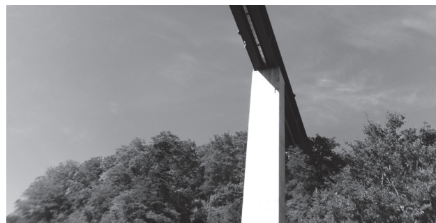
県内で最も高い橋となる八十里越の五号橋りょう橋脚
